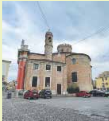
Padova. Complesso Chiesa del Torresino (foto Gianfranco Funari)
